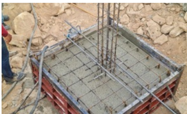
Beton armovaný ocelovými tyčemi (železobeton)
