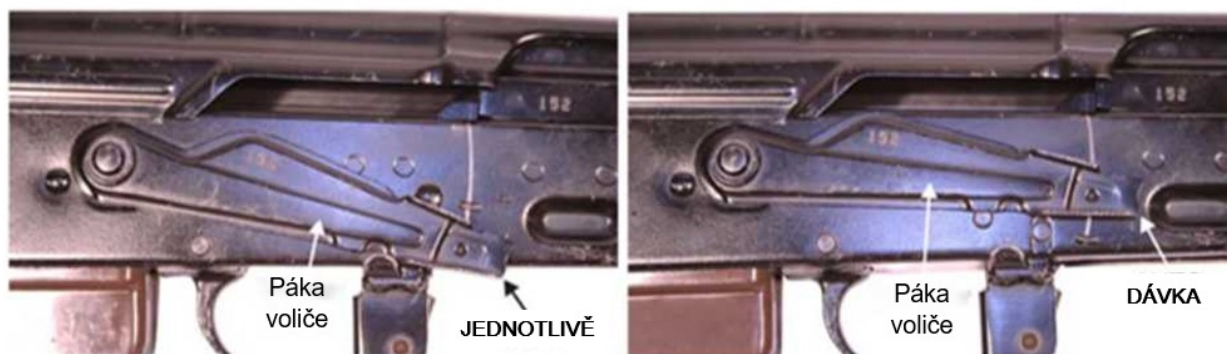
Obrázek 3. Páka voliče pro střelbu jednotlivými výstřely (vlevo) nebo dávkou (vpravo).
