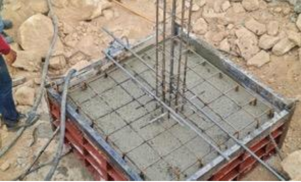
Çelik çubuklarla (inşaat demiri) güçlendirilmiş beton
