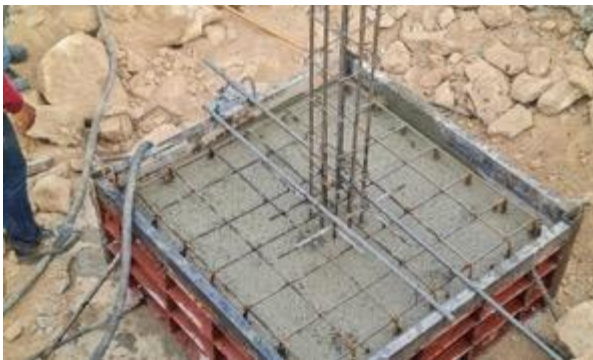
鉄筋コンクリート
