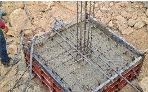
用鋼筋加固的混凝土
