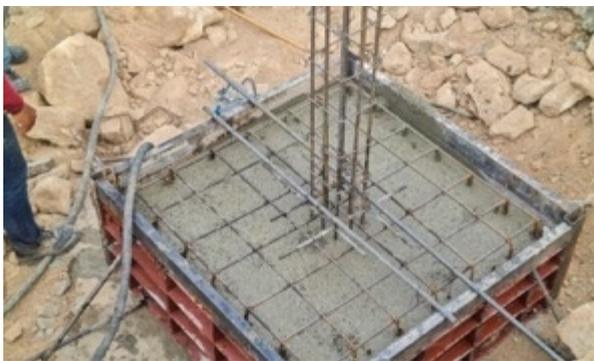
Hormigón reforzado con barras de acero
